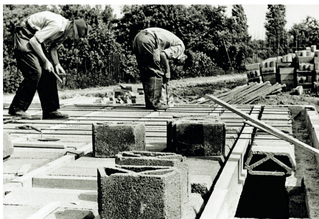
In der Anfangszeit des GSW in den 1950er Jahren halfen die Siedlungswilligen selbst beim Bau ihrer Wohnungen mit.
